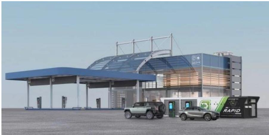
FC出力150kW以上で最大4台の車両を同時にDC急速充電することが可能、フル充電までの目標時間は約20分、内蔵タンクの水素で100台以上を急速充電できる可能性
