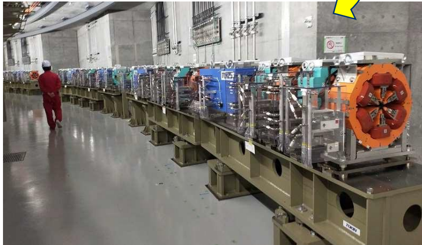
蓄積リング設置 電磁石セル (偏向電磁石:64台, 四極・六極電磁石:各160台)
