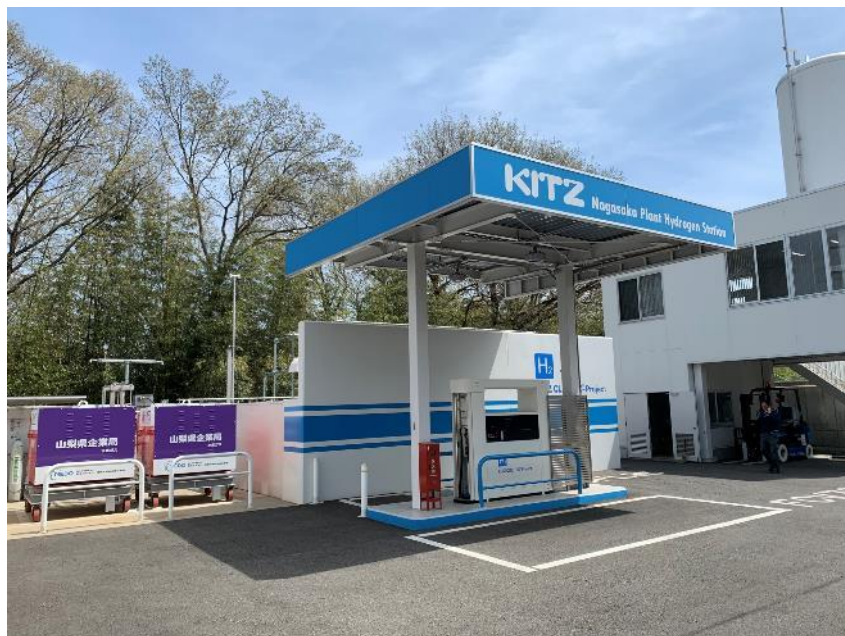
【キッツ長坂工場水素ステーションへ納入された米倉山産グリーン水素】
