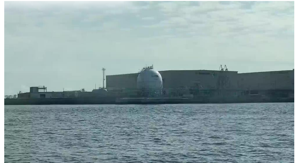
※液化水素 荷揚基地 (神戸空港島)
